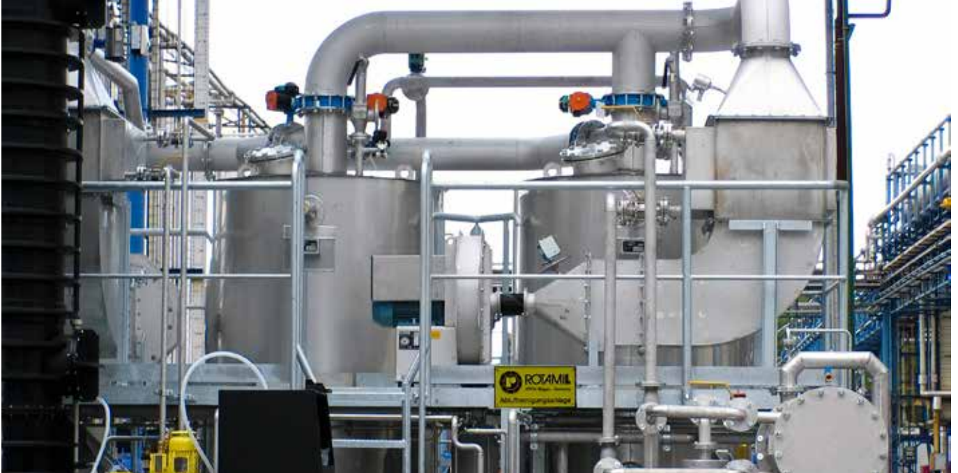
Der ROTAMILL-AKTIVATOR ist eine Aktivkohle-Anlage zur Lösemittel-Rückgewinnung.
