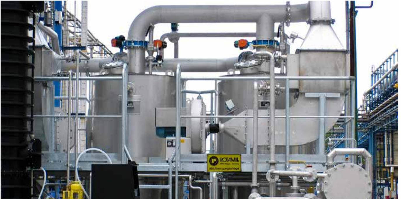
Der ROTAMILL-AKTIVATOR ist eine Aktivkohle-Anlage zur Lösemittel-Rückgewinnung.
